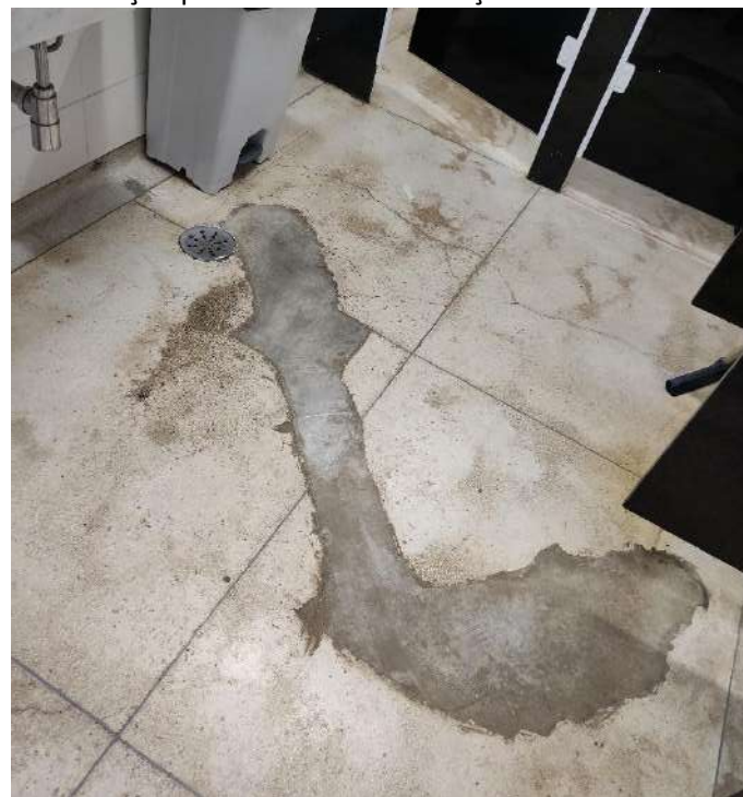
Foto 35. Detalhe do piso do Sanitário Masculino Coletivo.
