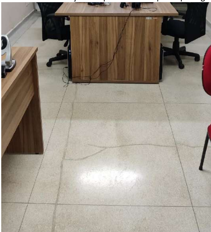
Foto 60 e 61. Exemplos de trincas no piso de granilite interno. Ocorrência de patologias no piso de granilite em praticamente a totalidade dos ambientes, apesar das frequentes operações de limpeza e manutenção.
