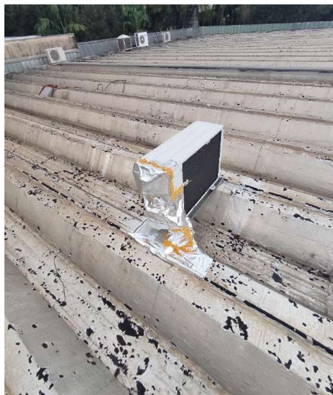
Foto 53. Impermeabilização improvisada do aparelho de ar condicionado (sala da Consultoria Técnica).
