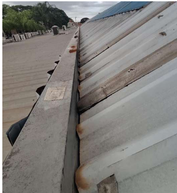
Foto 48 e 49. Cobertura sobre os hall/galeria e encontros com os oitões. Notar os pontos de remendos improvisados com manta aluminizada e a impossibilidade de manutenção e limpeza das calhas e condutores em razão da pequena abertura.
