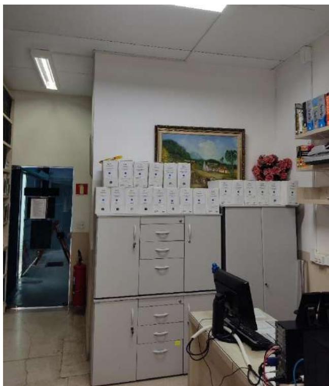
Foto 9. Sala da biblioteca. Mobiliário improvisado, caixas empilhadas sobre os armários.
