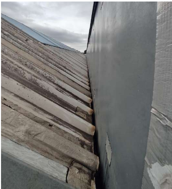
Foto 48 e 49. Cobertura sobre os hall/galeria e encontros com os oitões. Notar os pontos de remendos improvisados com manta aluminizada e a impossibilidade de manutenção e limpeza das calhas e condutores em razão da pequena abertura.
