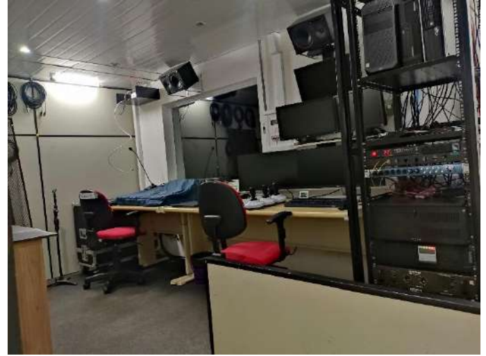
Foto 12. Sala Técnica do Plenário sem conexão adequada, servidor (fonte de ruído) no mesmo ambiente da técnica de edição.
