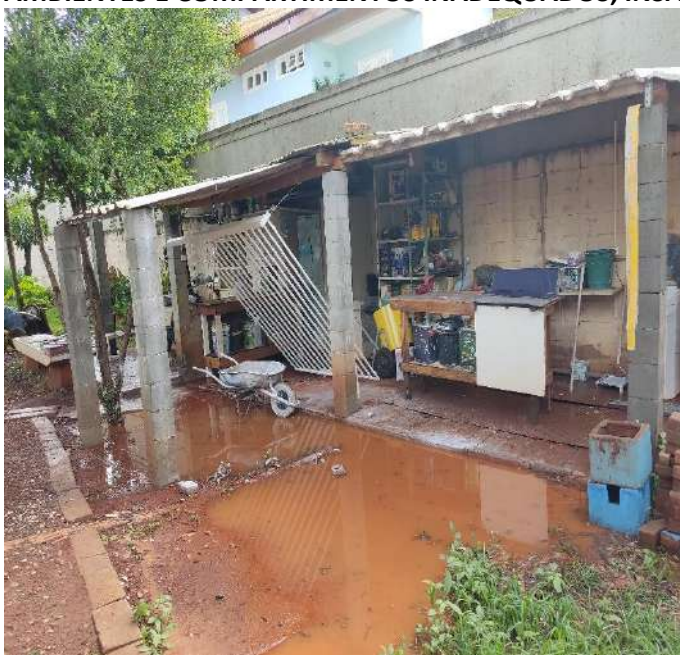
Foto 1. Oficina improvisada instalada na divisa lateral esquerda. Ausência de fechamento adequado, problemas de drenagem e pavimentação.
