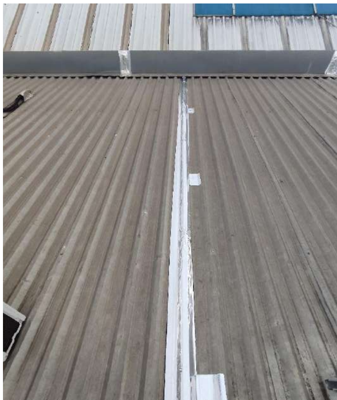
Foto 52. Remendo na junção de telhas sanduíche.
