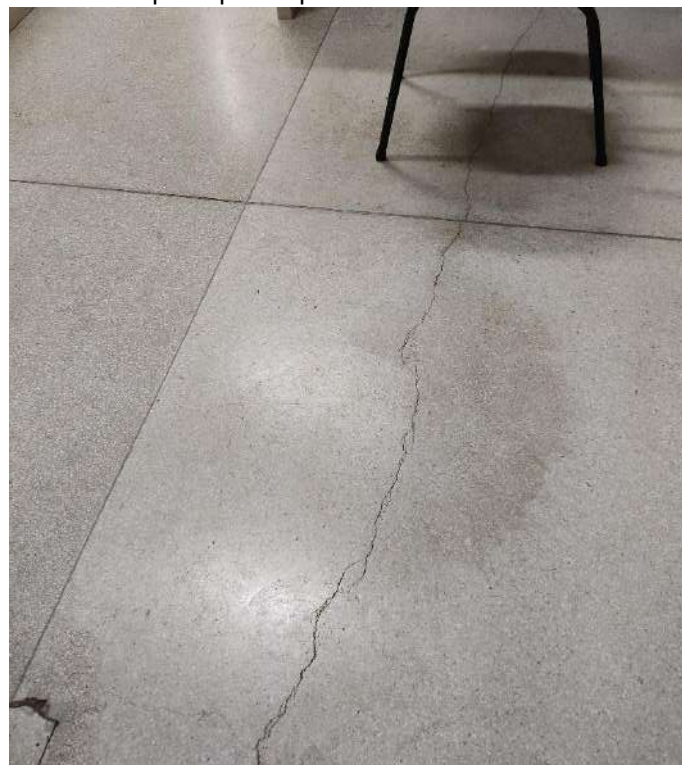
Foto 60 e 61. Exemplos de trincas no piso de granilite interno. Ocorrência de patologias no piso de granilite em praticamente a totalidade dos ambientes, apesar das frequentes operações de limpeza e manutenção.
