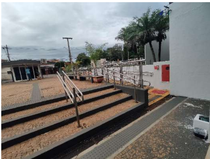
Foto 59 e 60. Condições do pavimento de pedra portuguesa na entrada principal do prédio.
