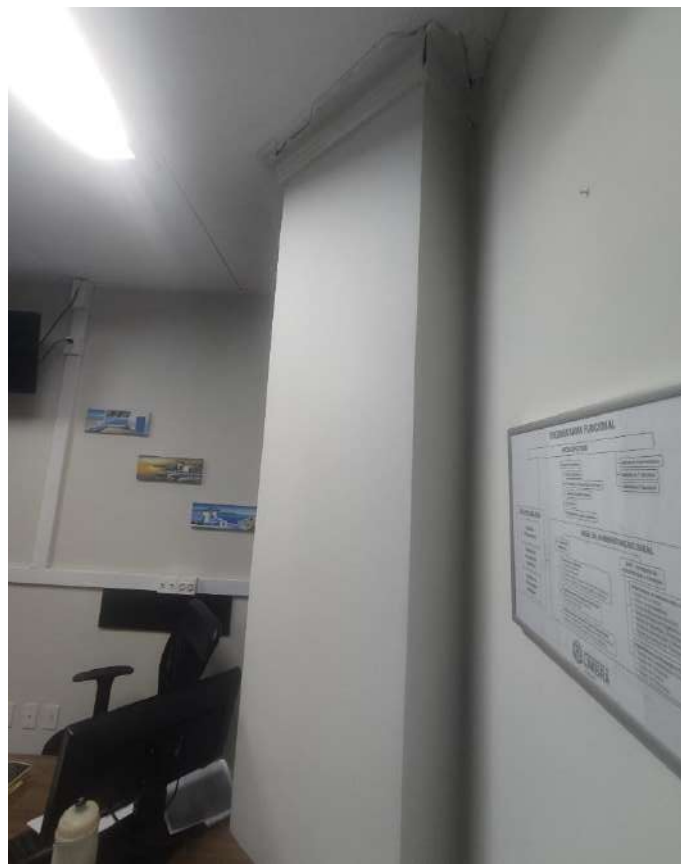
Foto 31. Elemento estrutural no meio do ambiente da Sala do Secretário Legislativo. Existem mais 4 ocorrências desse tipo em espaços de circulação e sala de reunião.
