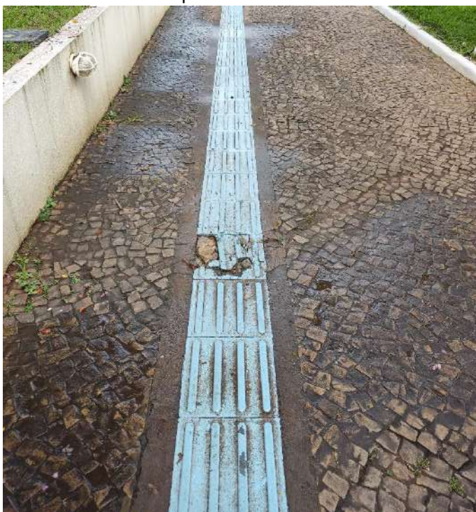
Foto 34. Aspecto do pavimento de externo de pedra portuguesa e piso de sinalização podó tátil.
