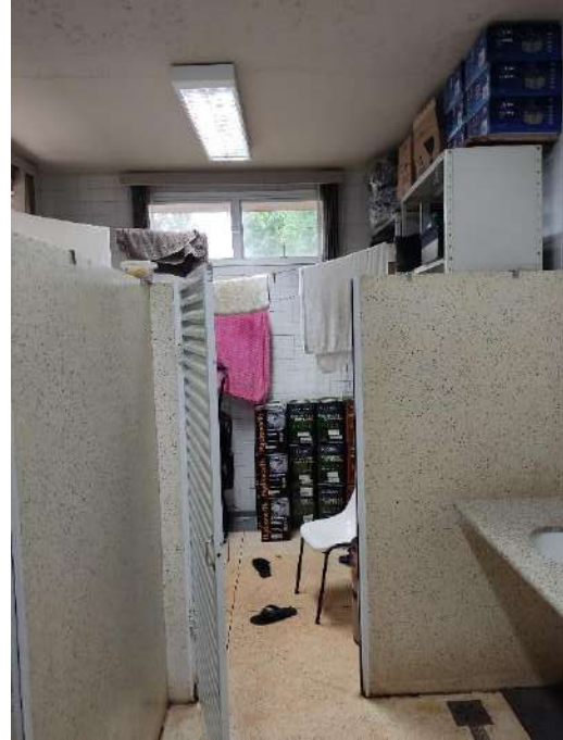
Foto 4. Sanitário e vestiário masculino do Bloco do Núcleo de Manutenção. Observar que parte do vestiário é utilizado como depósito de materiais. Varal improvisado
