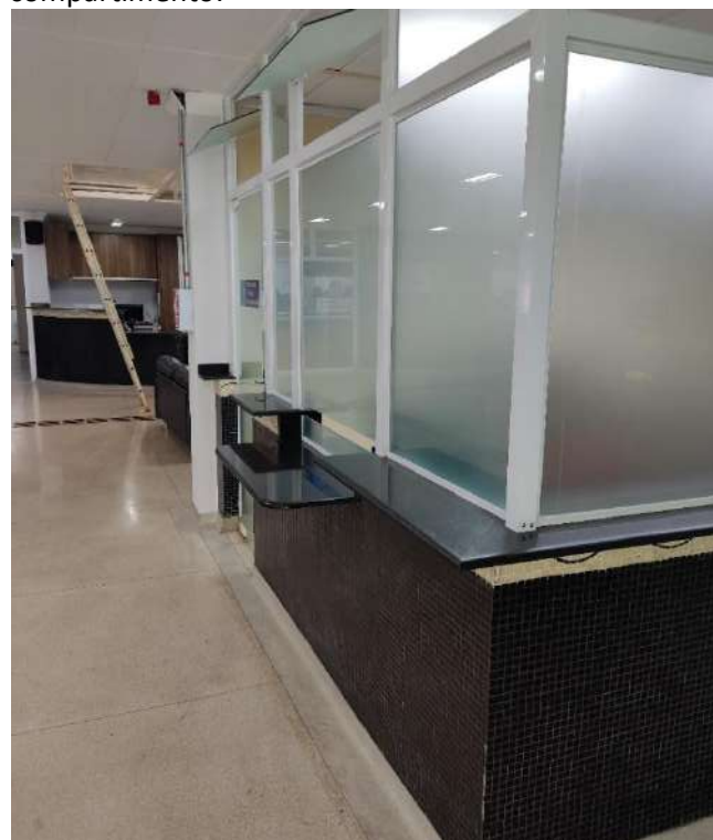
Foto 10. Sala da Consultoria Técnica Especializada. Fechamento improvisado executado sobre um balcão de um espaço que antes era uma recepção do plenário. A sala é localizada no hall, em área de grande circulação, sem aberturas para o exterior.
