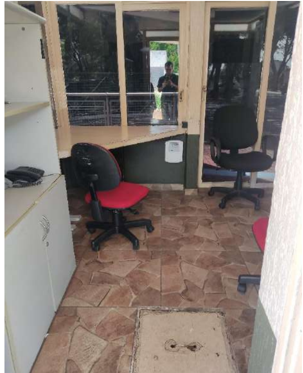
Foto 6. Condição do espaço interno da guarita.
