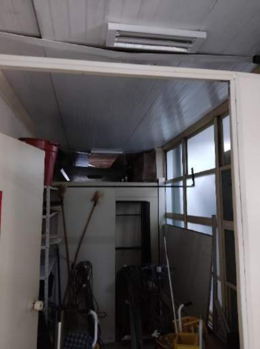
Foto 3. Almojarifado e depósito da manutenção situado de forma improvisada no corredor central atrás da sala do departamento de informática.
