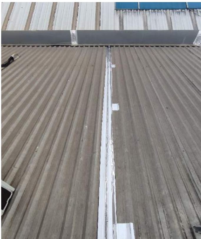
Foto 52. Remendo na junção de telhas sanduíche.
