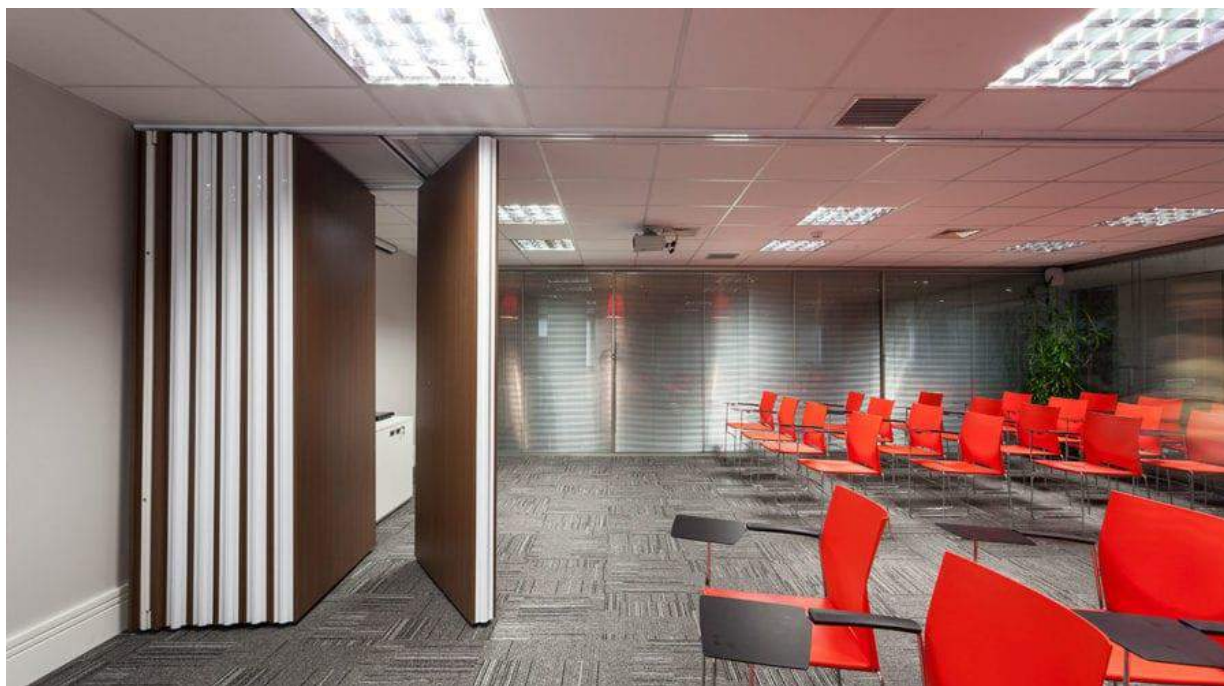
Figura 8. Exemplo de divisórias acústicas retráteis articuladas para divisão de salas de aula/treinamento. Fonte: https://www.divdesign.com.br/produtos/divisoria-retratil/ acesso em 28/02/2023.
