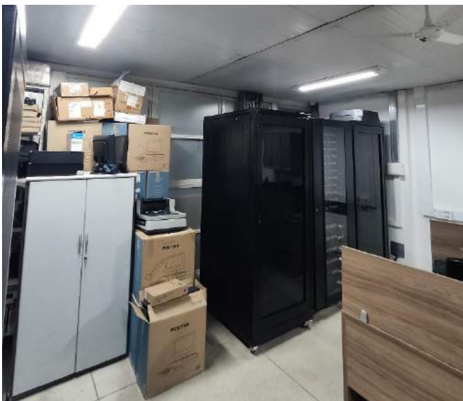
Fotos 19 e 20. Vista geral da Sala do Departamento de Tecnologia da Informação. Parte utilizada como almoxarifado. Servidor (fonte de ruído constante) sem isolamento junto aos postos de trabalho.
