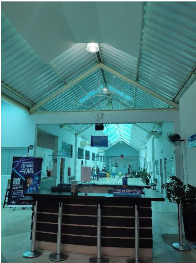
Foto 13. Recepção improvisada situada no hall/galeria dos gabinetes parlamentares. A identificação de público é realizada no interior do prédio.
